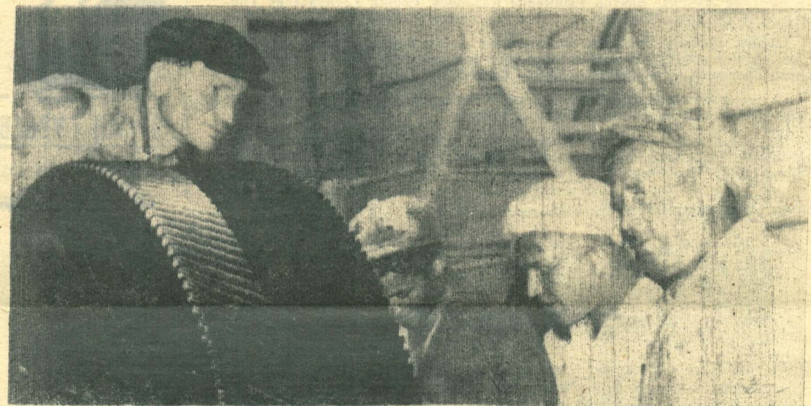
Бригада слесарей старшего мастера фабрики гидрофобной инертной пыли А. И. Бузмакова за ремонтом оборудования.
