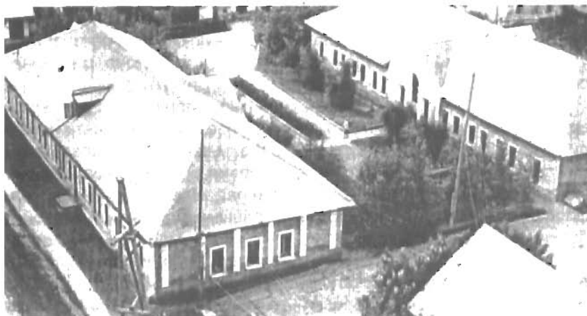
Контора стройуправления. Построена в октябре 1956 г.
