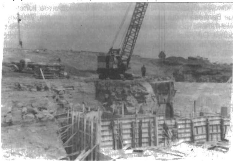
Гидроузел. Бетонирование подпорных стен водоотлива. 1961г.
