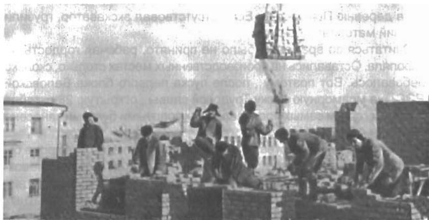
Кладку дома ведёт звено бригады Владимира Астафьева
