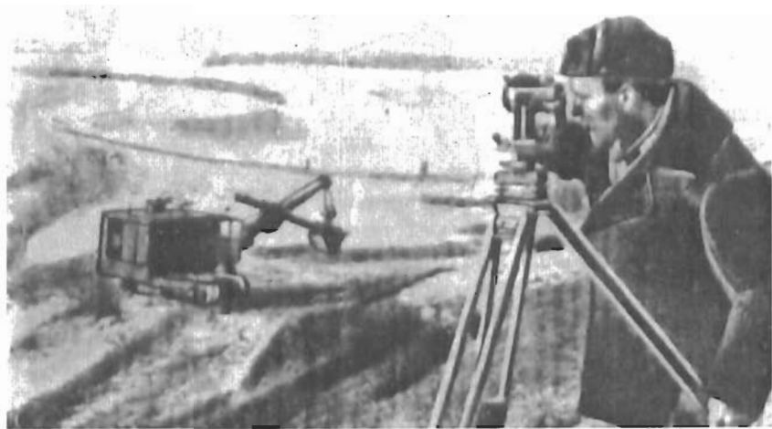
15 марта 1960 года началась разработка грунта в котловане главного корпуса электростанции
