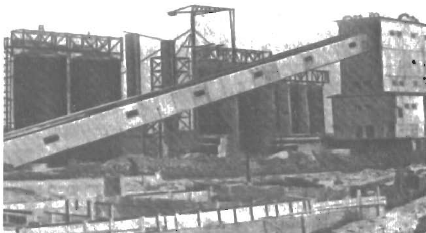
Бетонно - растворный узел. 1957 г.
