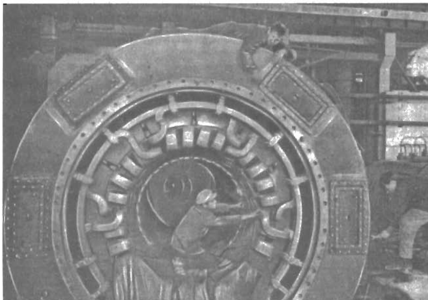
Монтаж первого турбогенератора. Август 1963 г.
