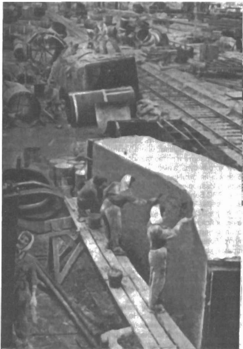
Укрупнительно - сборочная площадка. Женщины на зачистке и покраске блоков технологического оборудования. 1963 г.
