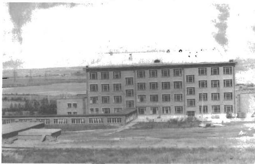
Главный корпус Беловского энергостроительного техникума (БЭСт), в настоящее время - политехнического колледжа
