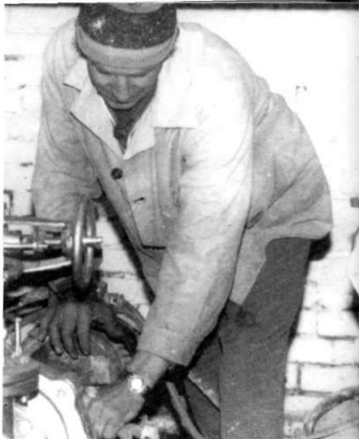
Ревизия насосно-сетевого оборудования в котельной поселка Нововосточного
