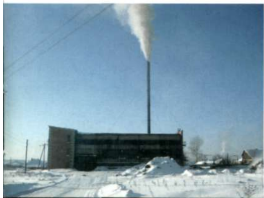
Котельная ремонтно-технического предприятия. 2005 год
