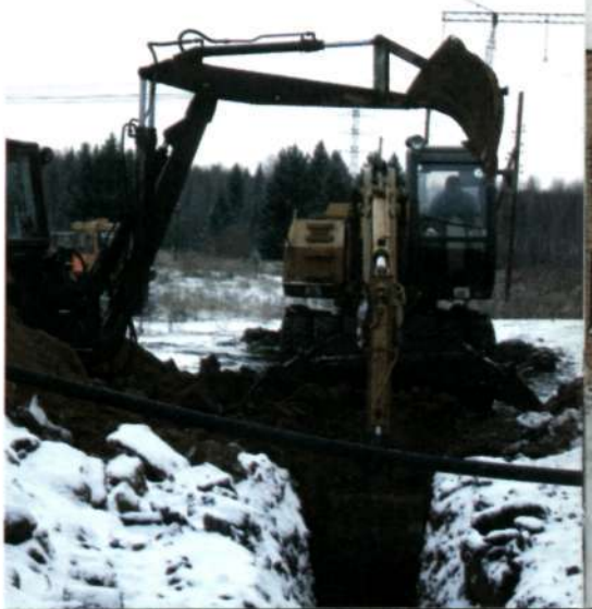
Прокладка водопровода
