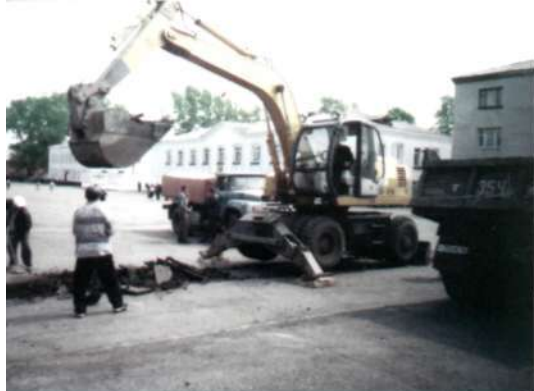
Работы по реконструкции площади имени В. И. Ленина в поселке Тяжиском
