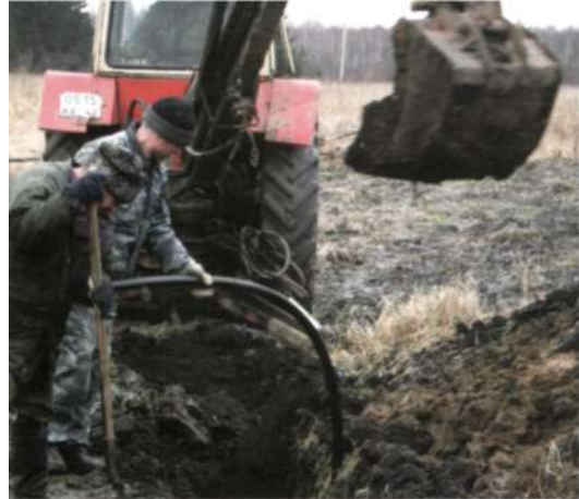
Прокладка полиэтиленовых водопроводных труб
