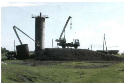
Замена резервуара на водонапорной башне в селе Листвянка
