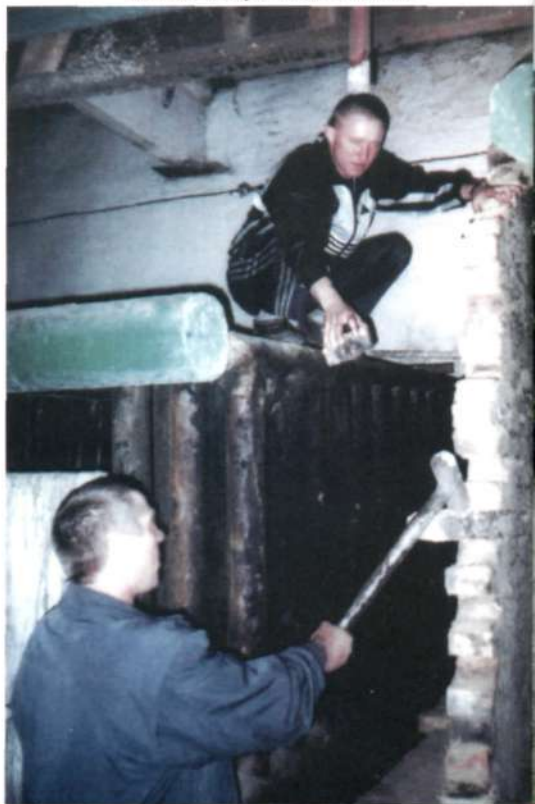
Ремонт котельной больницы Итатского участка. 2004 год
