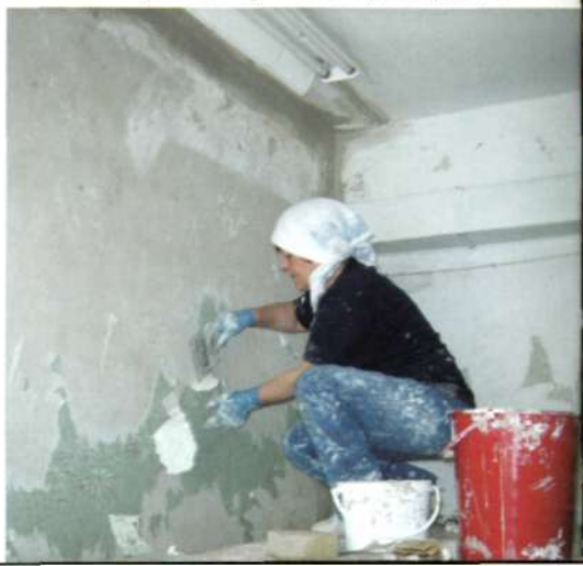
В этом помещении будет работать швейная мастерская по производству спецодежды
