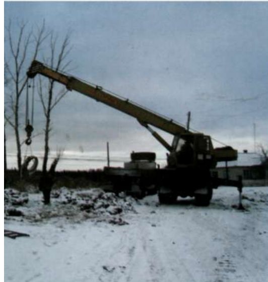
Монтаж водопроводных сетей в селе Старый Тязгин
