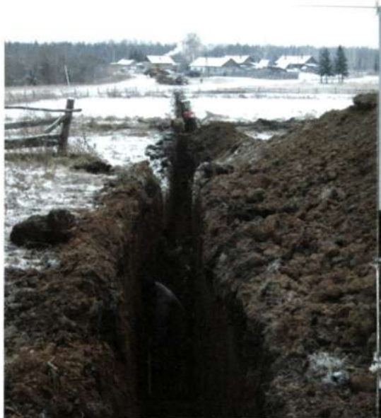
Строительство водопровода в селе Старый Тяжин
