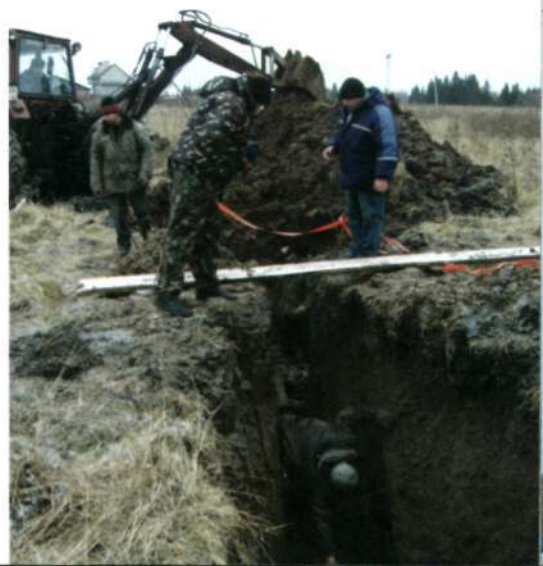
Водопровод в Старом Тяжине – на последних метрах
