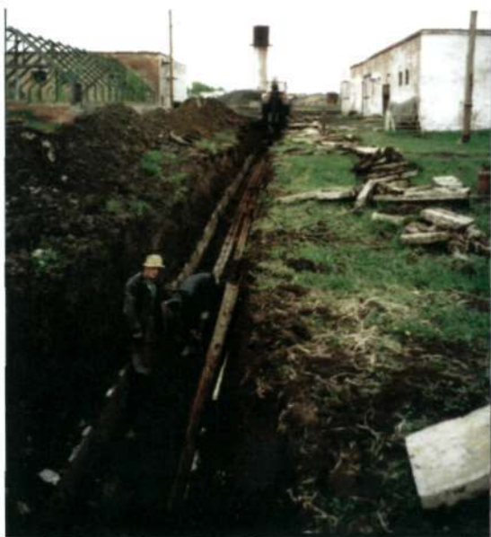
Реконструкция теплосети в селе Листвянка
