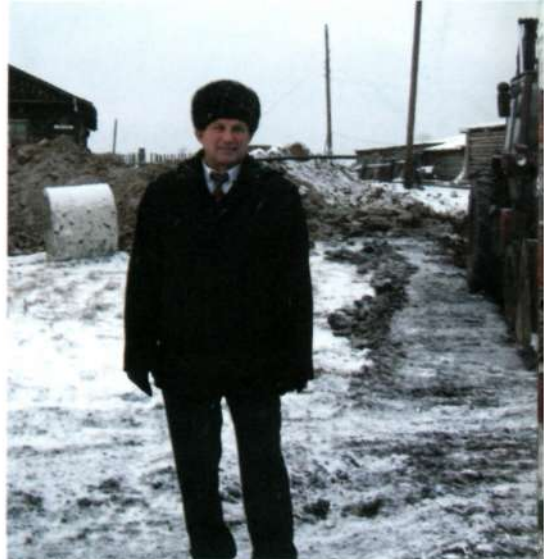
Директор МУП «Теплокоммуэнерго» С. А. Вережкин на объекте
