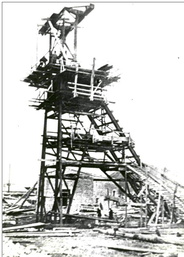
Монтаж копра клетьевой шахты, 1932
