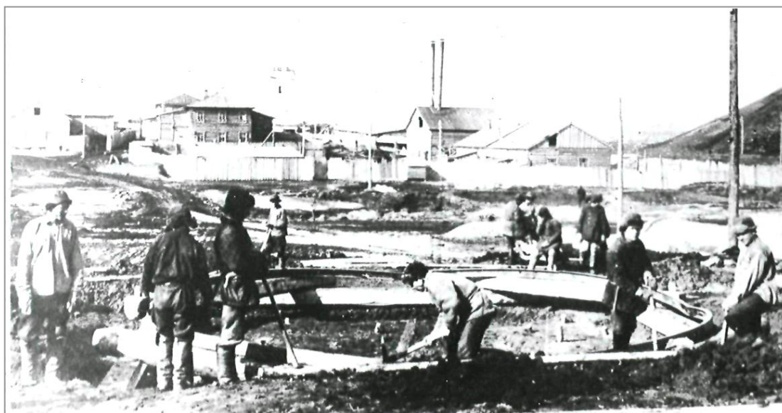
Октябрь 1929 года. Начало проходки шахты «Скиповая».
